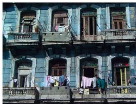
Réfection des balcons par remplissage de parpaings.
